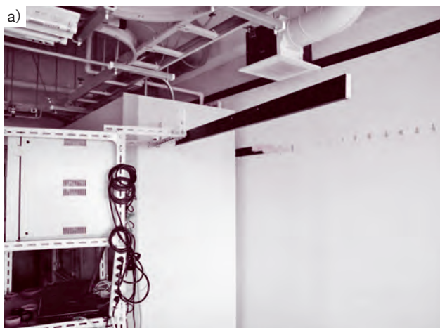
図3 剥がれる画枠、抜ける耐震
